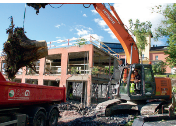
Anleggsarbeier, Fornebu, Isachsen Anlegg
