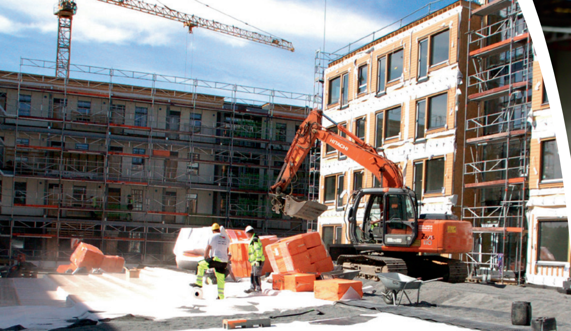
Membran- og dekkearbeider, Lørenskog Stasjonsby, Selvaag Bolig
